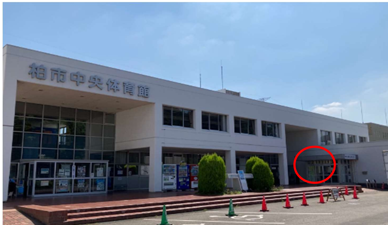
柏市中央体育館 管理棟 1階
